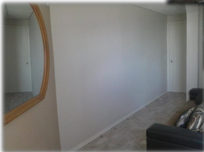
ACCESO ESTANCIA MÉDICA Y VESTIDOR PREVIA AL INGRESO DE QUIROFANO 1
